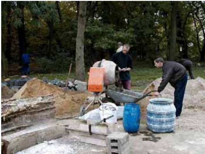
Abbildung 13: Ernst & Frank am Betonmischer
